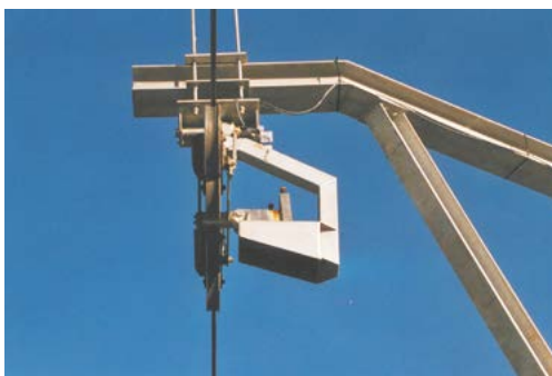
Quelques clichés pris par Pierre-Denis Perraudin en 2008, sur le chantier du téléski en Serbie.
